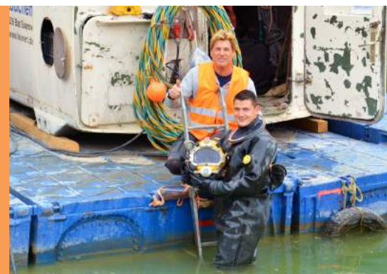
Taucher mit Spezialausbildung auf der Baustelle in der Steinhäuserstraße
