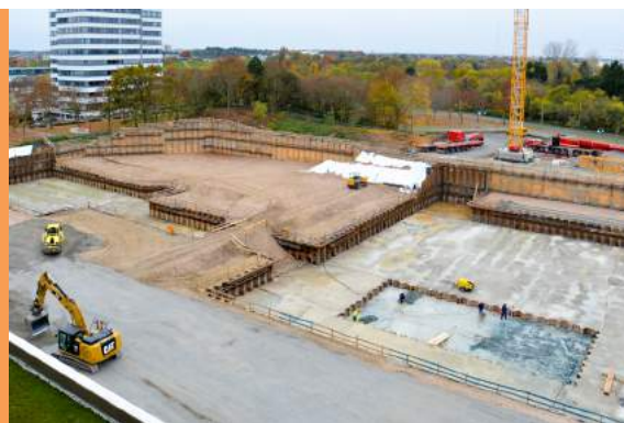
Eindrucksvoll: die zwei Meter dicke Betonsohle
